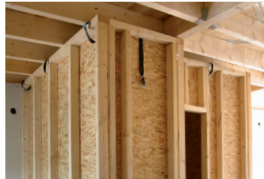
Drvene konstrukcije i zidovi
